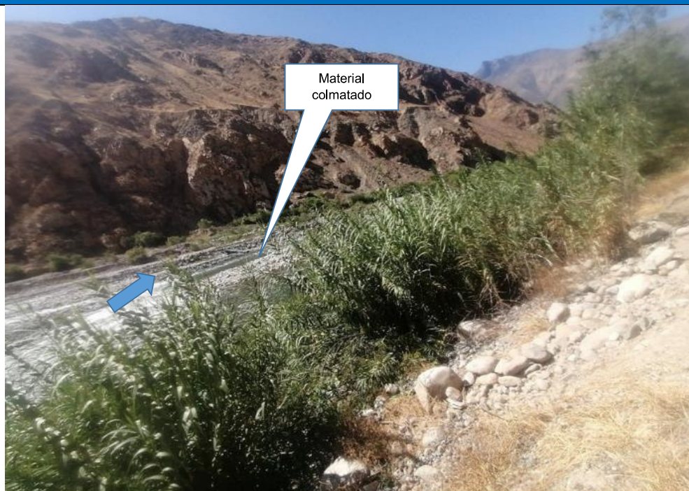
FIGURA N°01: TRAMO CRÍTICO, PUNTO DE INICIO AGUAS ABAJO, MATERIAL COLMATADO
